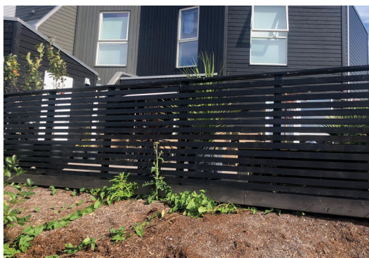
Eksempel på rekkverk med toppbord i tre.
