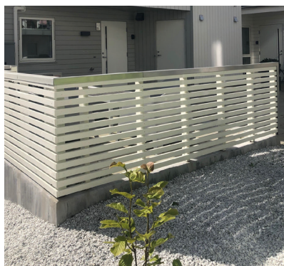
Eksempel på rekkverk med toppbord i aluminiumsbeslag.
