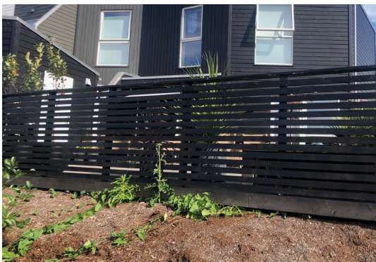
Eksempel på rekkverk med toppbord i tre.
