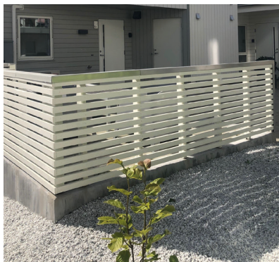
Eksempel på rekkverk med toppbord i aluminiumsbeslag.
