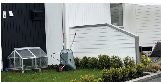
Eksempel på levegg med liggende kledning og toppbord i aluminiumsbeslag.
